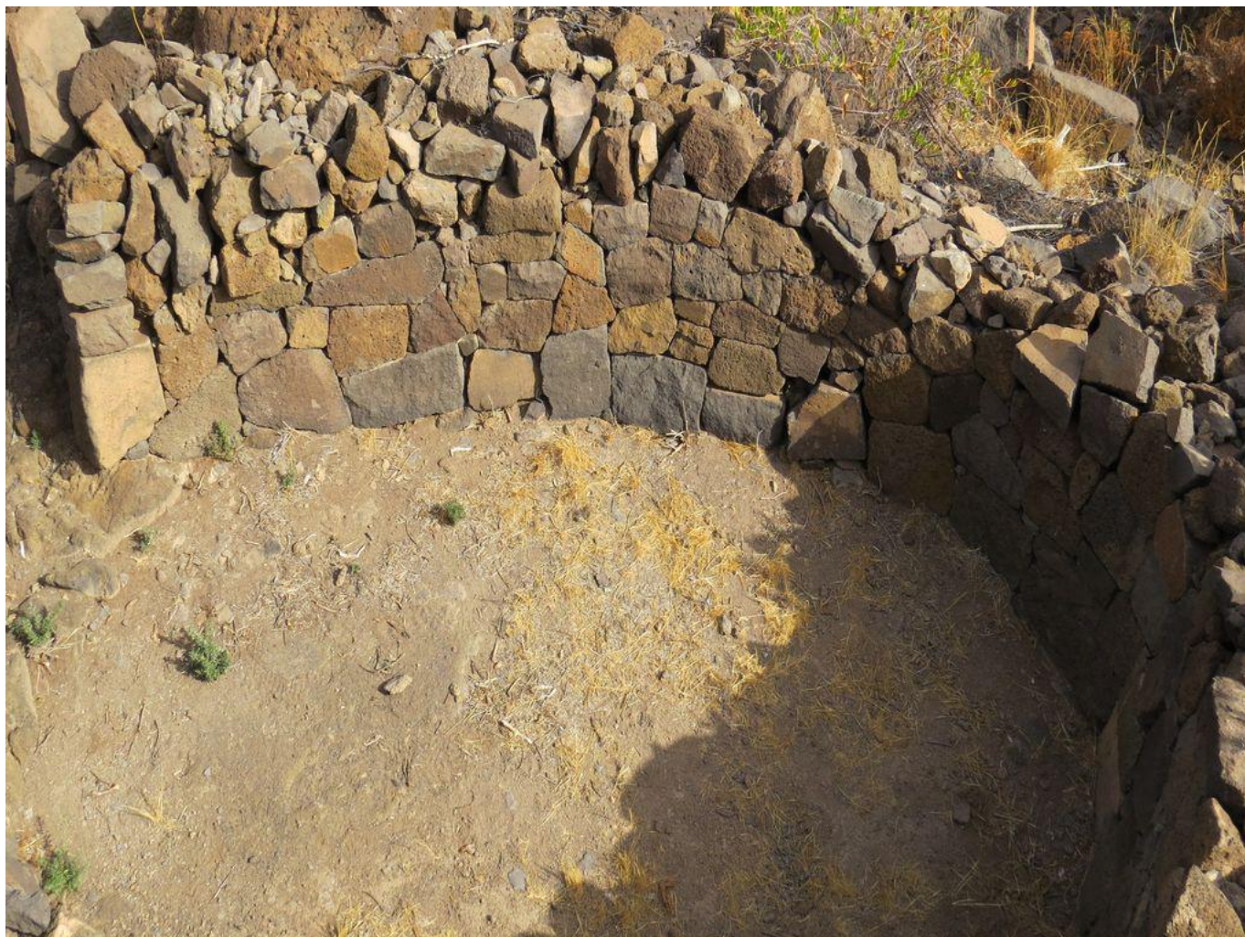
Estructura en la cima
